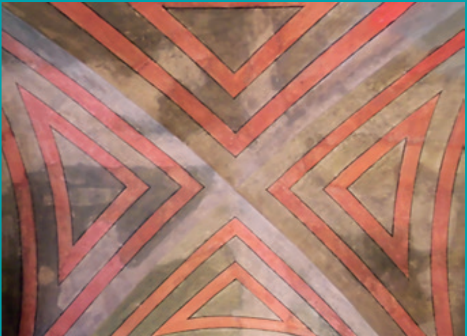
Bóveda vahida del edificio del Teatro, Peso y Carnicería situado en la plaza Mayor de Aranda de Duero. José Muguerra (1776). Actual Ciavín. Foto Fco. Javier Iglesia.
