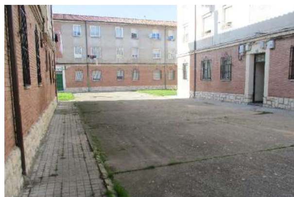
Fig.06: Espacio entre bloques en Pza. Montehermoso.
