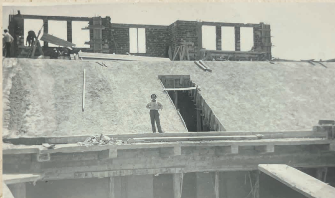
Construcción del graderío del Cine (25 de mayo de 1934). Foto de la familia Berrojo Romera
