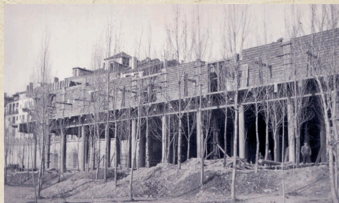
Construcción del Cine Aranda
