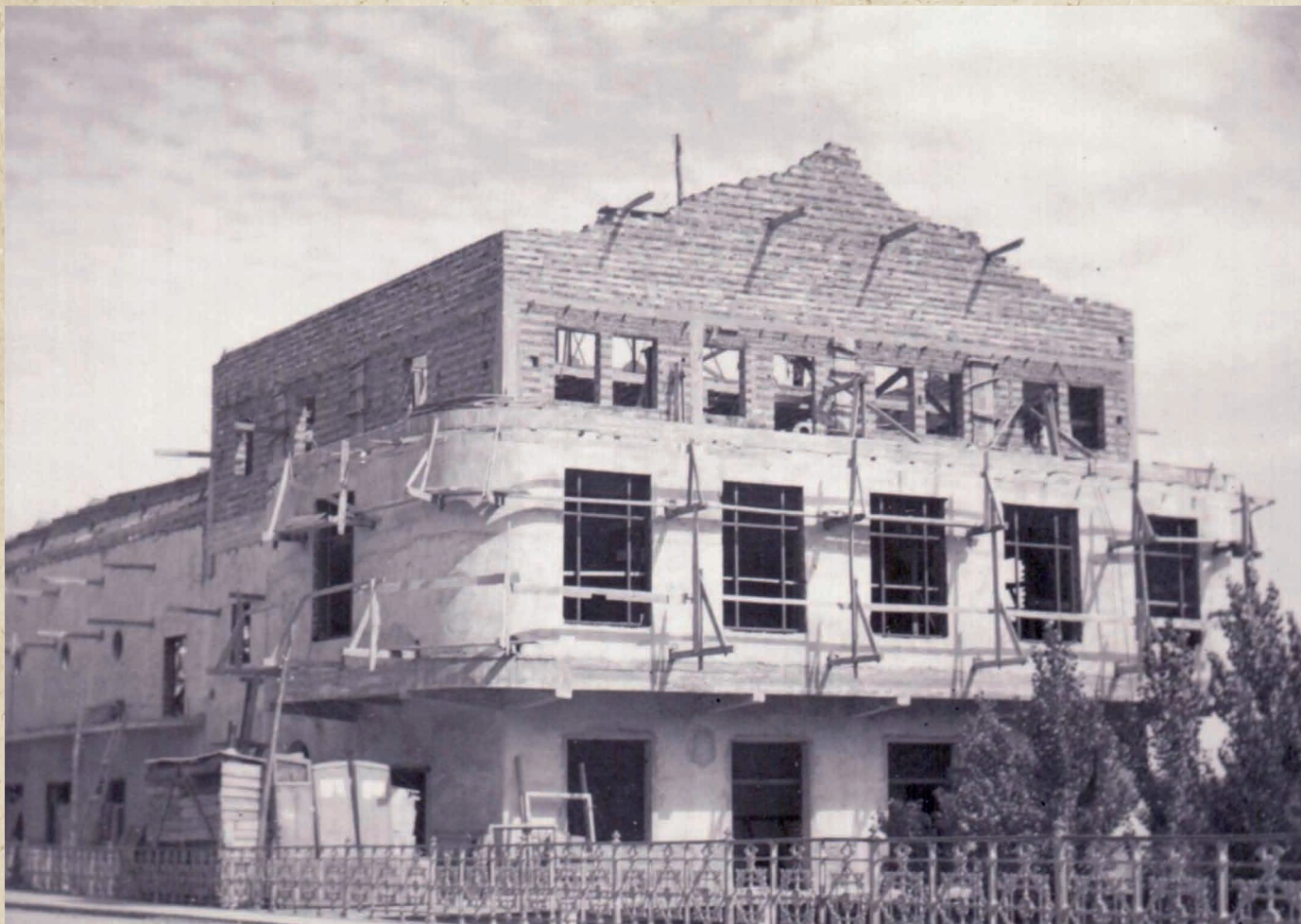
El Cine Aranda en obras en 1934
