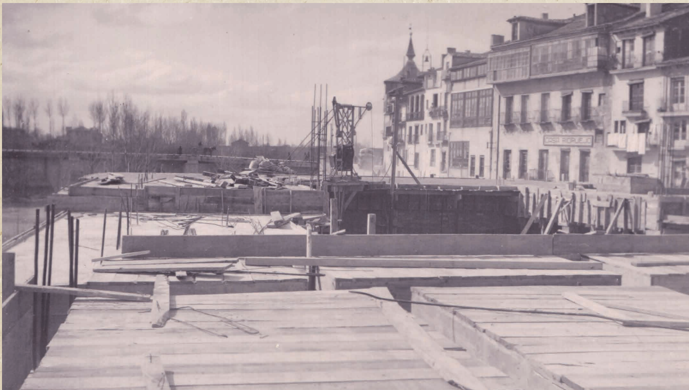
Vista general de las obras del Cine (24 de marzo de 1934)
